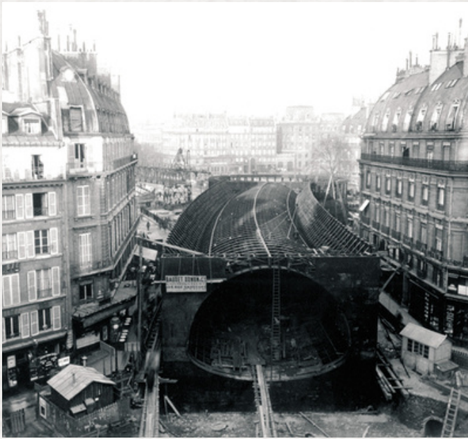
Les travaux du Métropolitain
